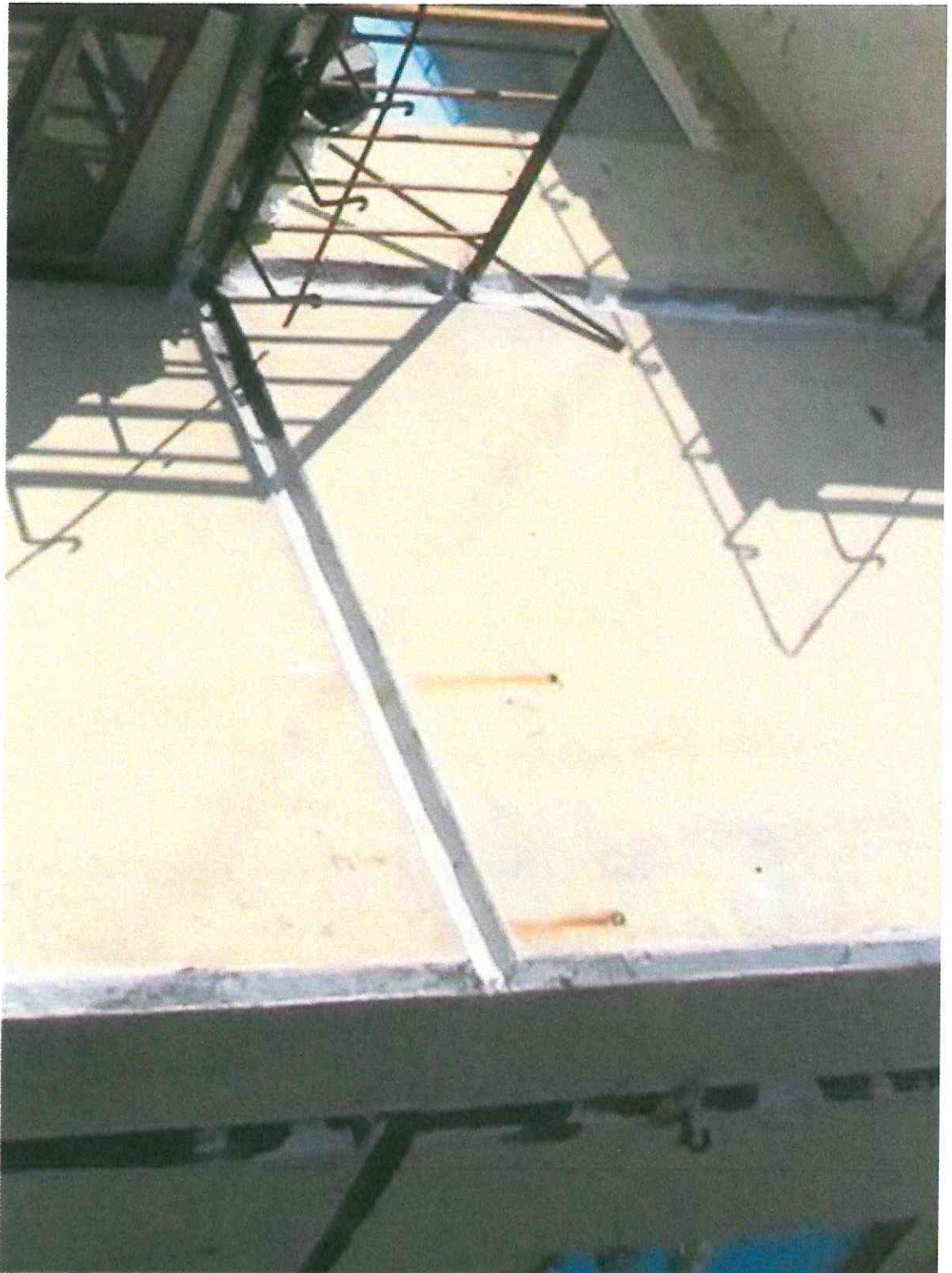
Образование «дутьиков» шлакового заплотнителя на фасаде
