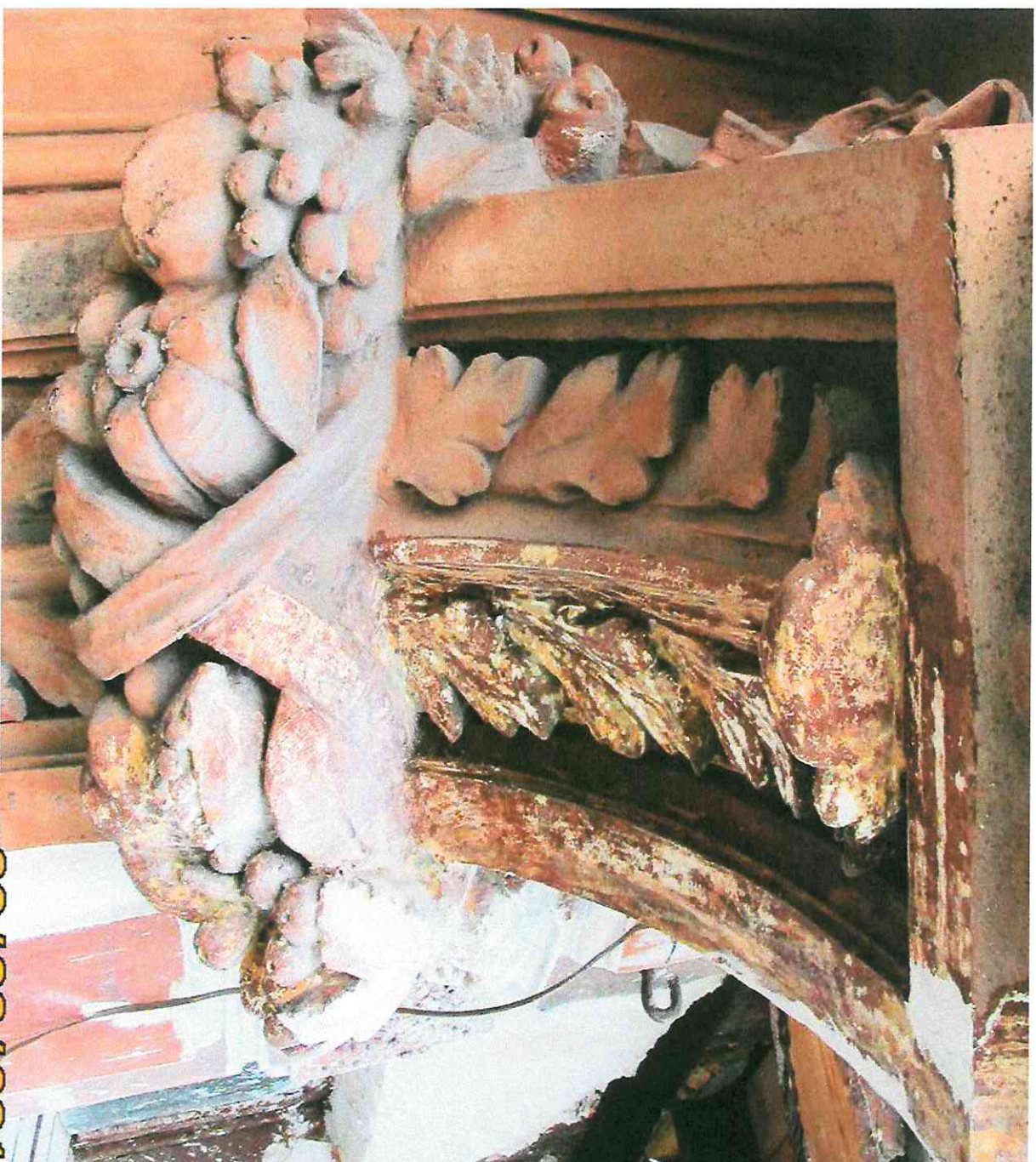
Иллюстрация №14 Расчетка ленины связками для удаления старой краски
