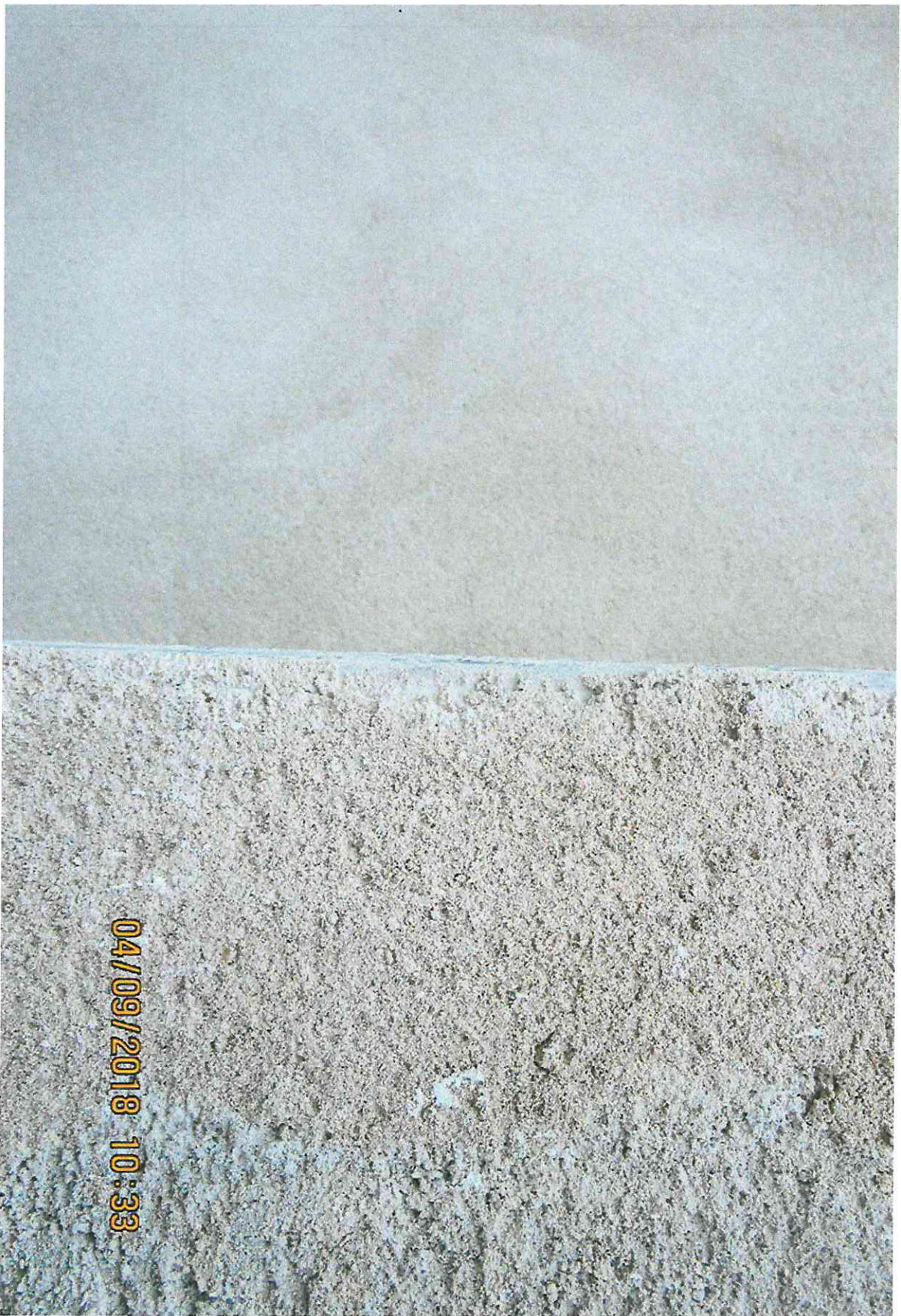
Иллюстрация №8 Слева - шероховатая штукатурного слоя накрывочной штукатурной смеси или грубозернистой шпателькой фракцией до 0.63 мм, справа – грубозернистый штукатурный слой с фракцией наполнителя до 2.5 мм
