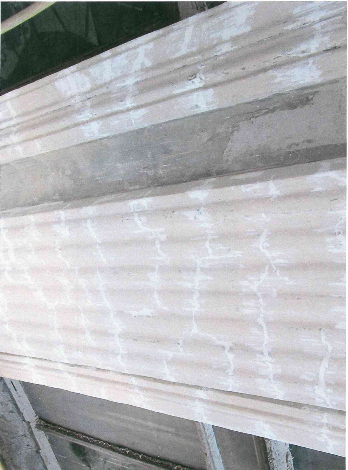
Иллюстрация №11 Заполнение дефектов расщипленного основания мелкозернистой шпательной на сдир.
