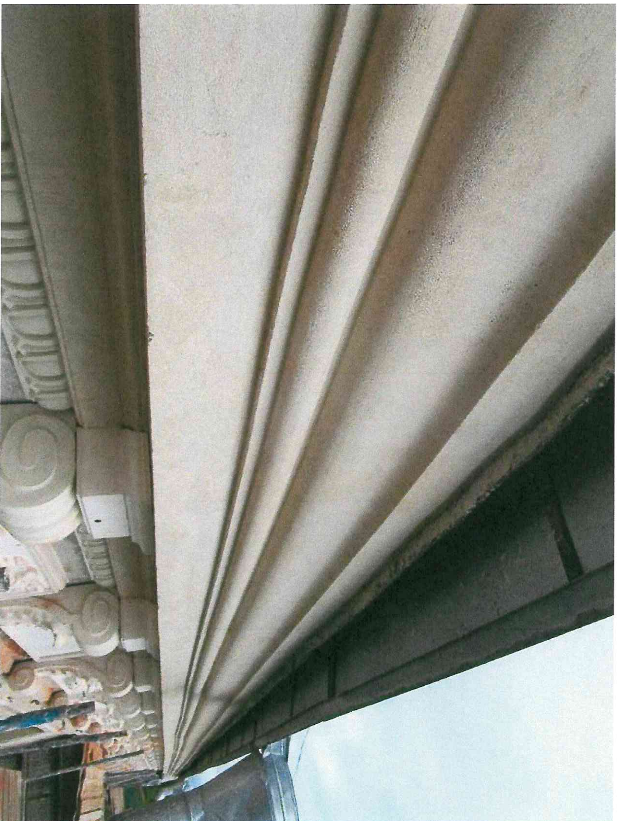
Иллюстрация №13 Протягивание профилированных тяз по шаблонам в финишной (накрасочной) шпукатурке
