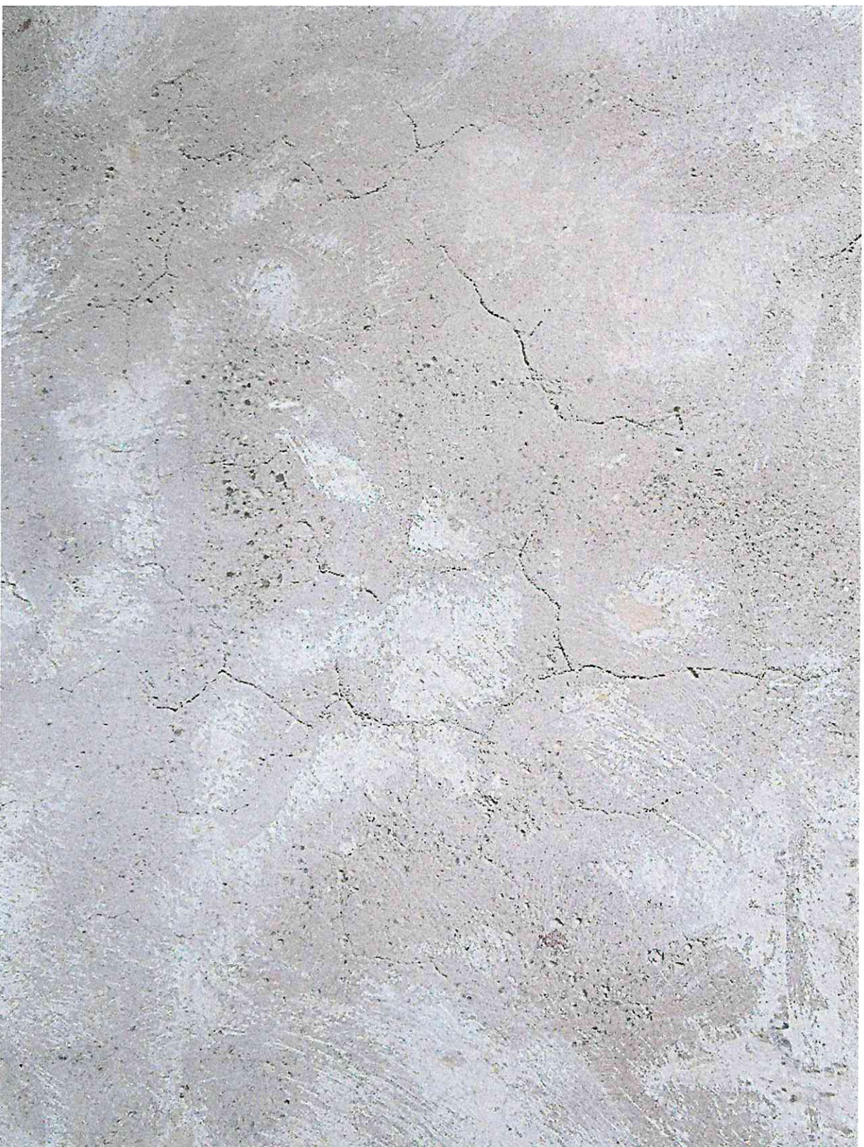
Иллюстрация №2 Расчетка красочных и пигментных наслоений шлифовкой
