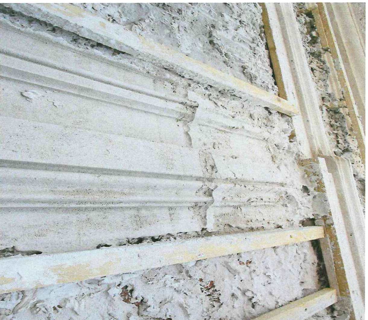
Иллюстрация №12 Протягивание профилированных мая по шаблону в грубозернистой штукатурке
