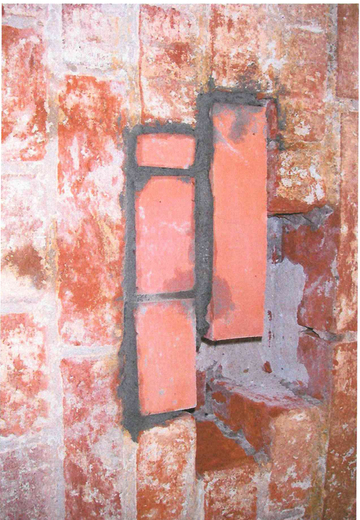
Иллюстрация №4 Ремонт кирпичной кладки с установкой нового кирпича на сложный кладочный расшивор
