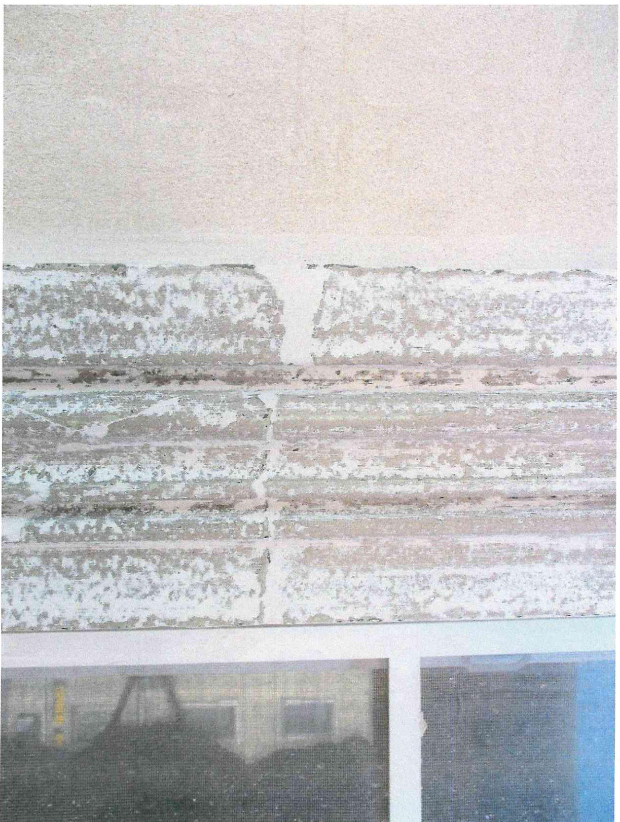
Иллюстрация №10 Заделка дефектов профилированного элемента с защиткой до состояния на сдир
