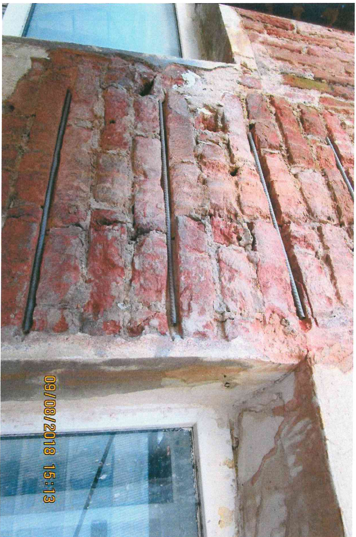
Иллюстрация №6 Установка арматуры в кладочный шов. Предварительное заполнение шпательной ложкой раствором обязательно.
