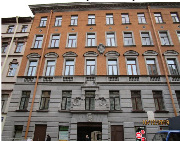
ПОСЛЕ КАПРЕМОНТА Моховая ул., д. 26, литера А
