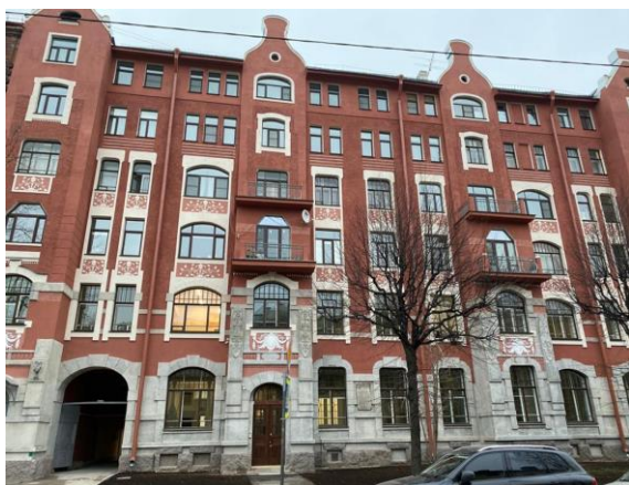
ПОСЛЕ КАПРЕМОНТА ул. Красного Курсанта, д.25
